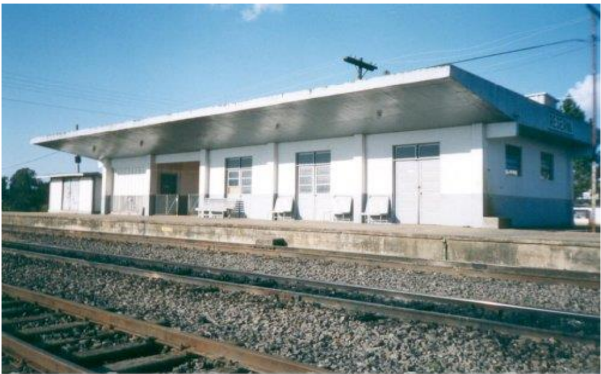
Figura 9 – Estação Ferroviária de Reserva em Atividade Fonte: Disponível em www.estacoesferroviarias.com.br . Acessado, abril/2015
