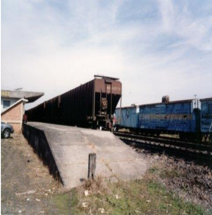
Figura 8 – Estação Ferroviária de Reserva em Atividade Fonte: Disponível em www.estacoesferroviarias.com.br . Acessado, abril/2015
